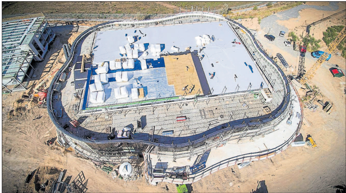
DIESES AKTUELLE LUFTBILD ZEIGT die Baufortschritte des Erlebniszentrums auf dem Gelände der Klima Arena Sinsheim. Der Klimawandel und seine Folgen sollen hier erfahrbar werden. Foto: Tobias Schwerdt
